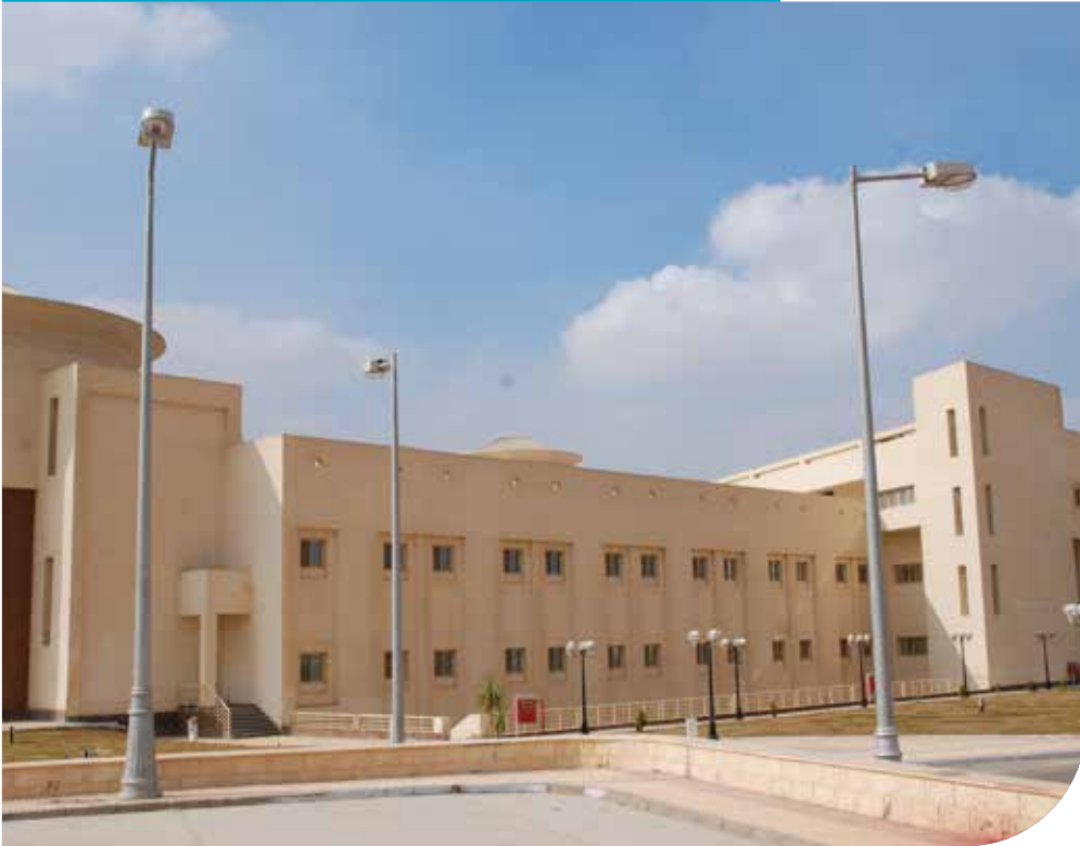
Hôpital des forces aériennes - Le Nouveau Caire
