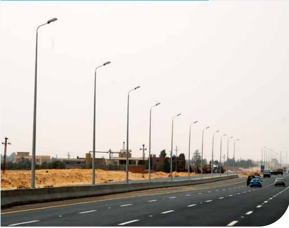
Autoroute du Caire - Alexandrie
