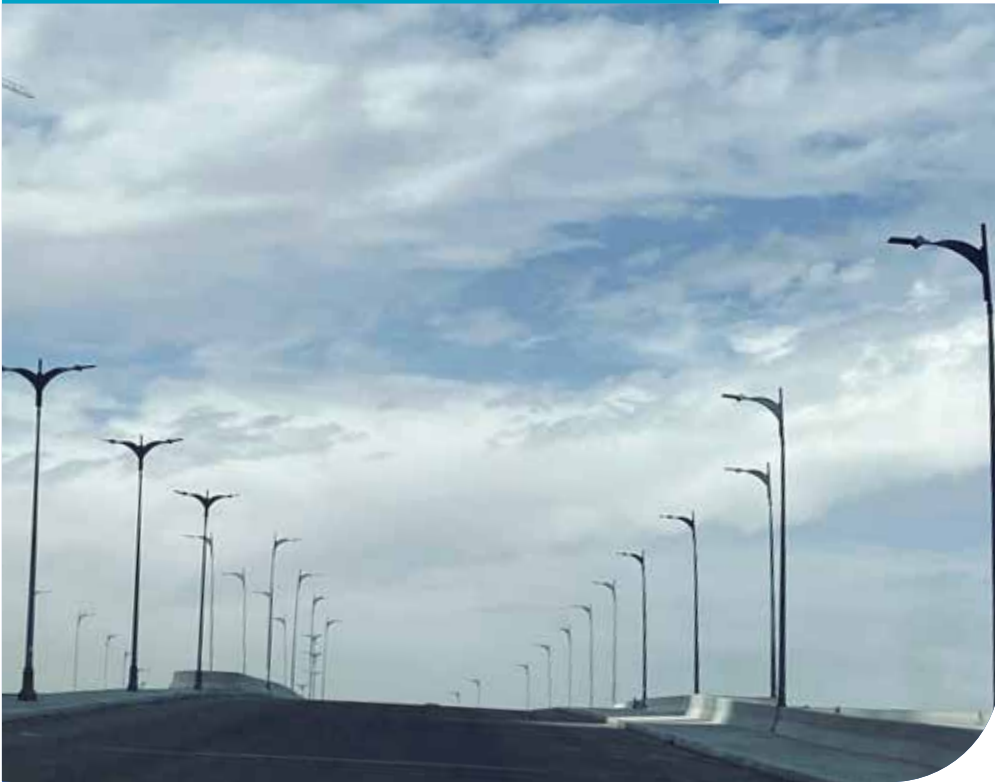
Poteaux d'éclairage public
