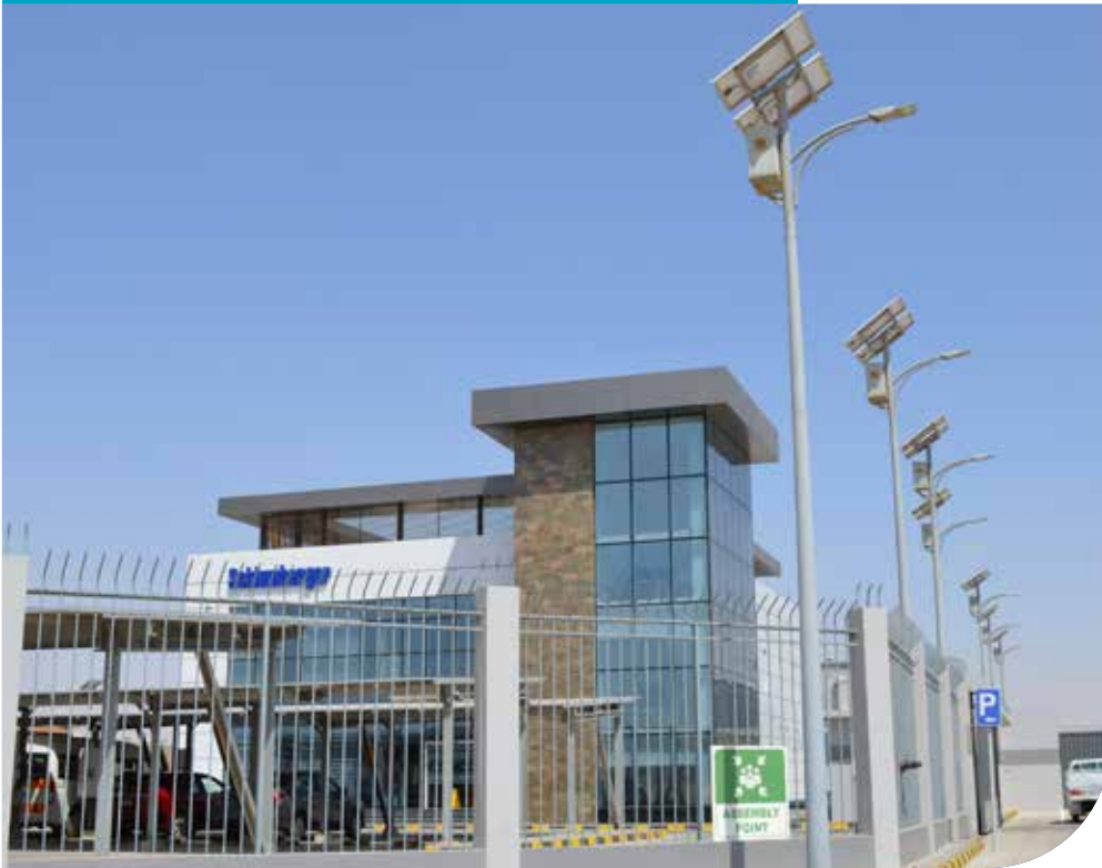
Poteaux à énergie solaire
